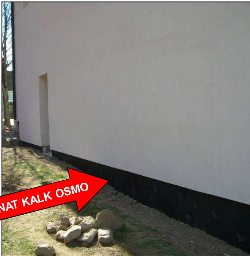
Composto cementizio osmotico bicomponente a base di leganti idraulici e resine flessibilizzanti per la realizzazione di rivestimenti protettivi impermeabili
